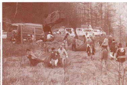
刈り草を琴川ダム残土処分場に運び入れて、緑化を推進(藁置き工法)
