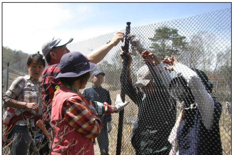
上：遊歩道の杭打ち。中：シカ柵の支柱2.5mおきに地面に打ち込む。下：支柱にプラスチック製の網を固定していく。
